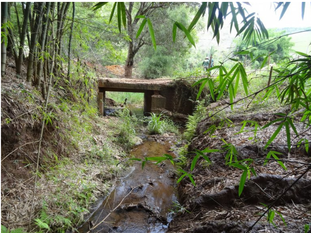
NTC05 b: Galeria. Detalhe para camada espessa de deposição de rejeito e processos erosivos
