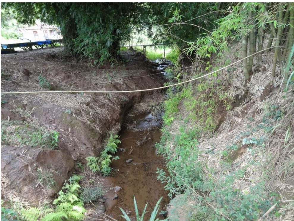
NTC05 d: Detalhe para o sombreamento ocasionado pelos bambuzais e deposição de material vegetal
