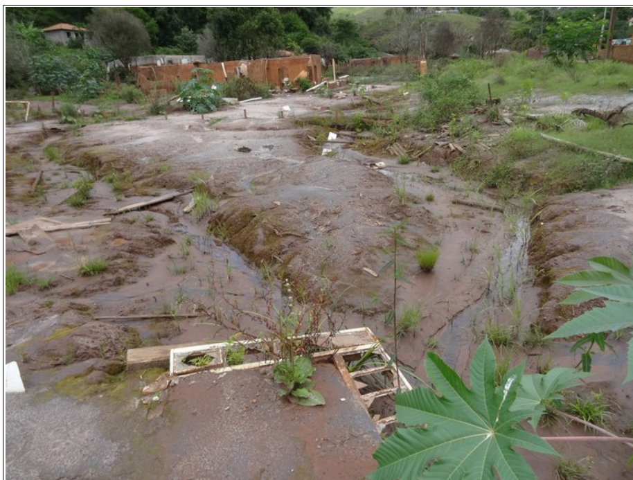
NTG 02 a: Detalhes do tributário sobre camada de rejeito, perímetro urbano do Distrito de Paracatu de Baixo.
