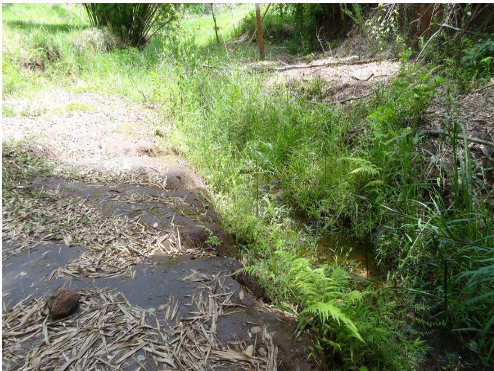
NTG11 c: Detalhe para elevada deposição de rejeito.
