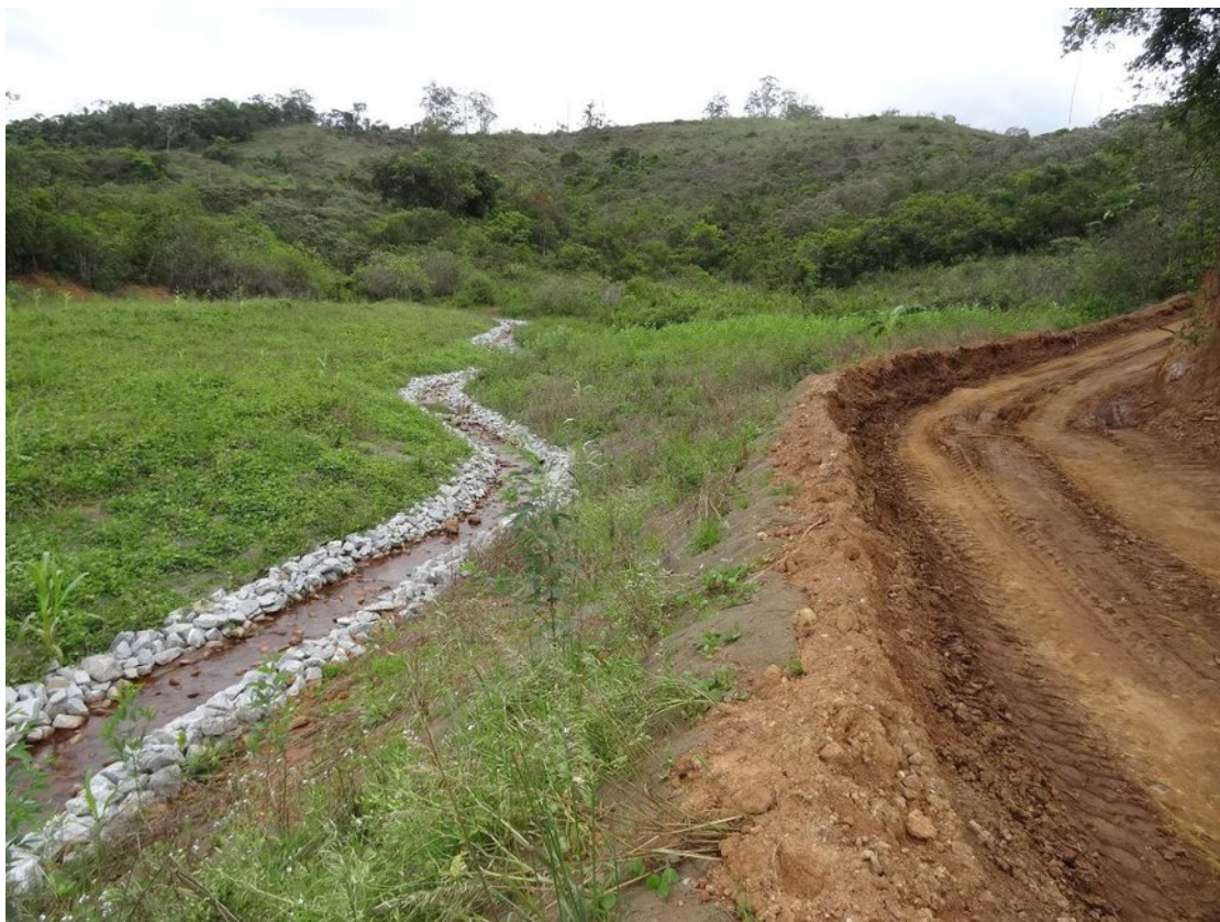
ITS 15 a: Terço médio do tributário, reconformado e com cobertura vegetal; detalhe para estrada de acesso.
