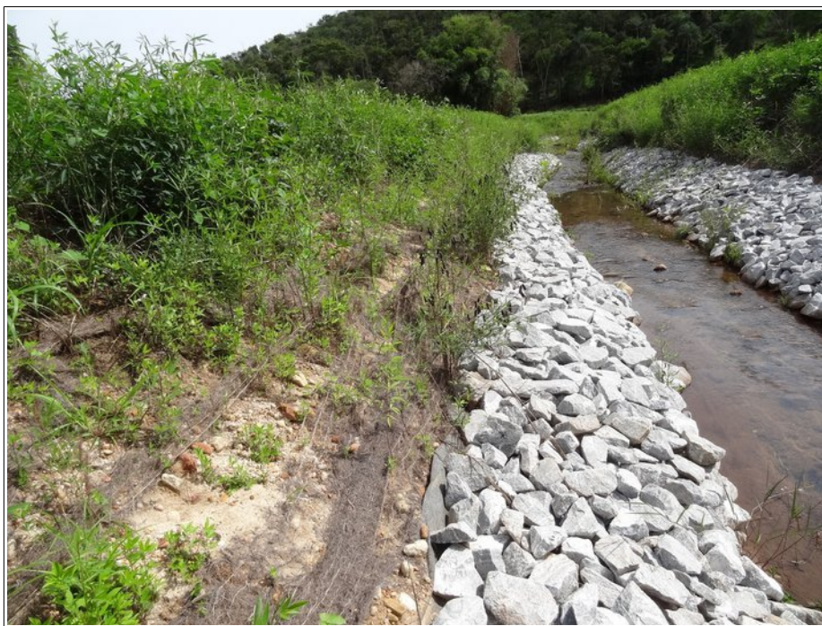
ITG 35 a: Detalhes da reconformação do tributário, enrocamento, biomanta e mix de gramíneas e leguminosas.
