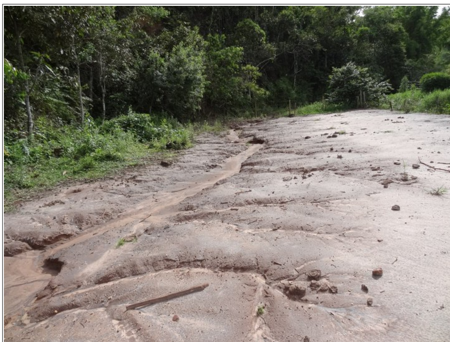
ITG 35 d : Camada de rejeito exposta e em franco processo de ravinamento à montante do tributário.
