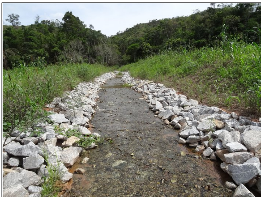
ITG 38 b: Detalhes da reconformação do tributário, enrocamento, biomanta e mix de leguminosas/gramíneas.
