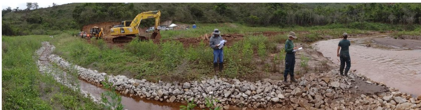
ITS 15 d: Terço à jusante (foz no Rio Gualaxo do Norte), com ações emergenciais em andamento durante a vistoria, registrada a presença de máquinas e trabalhadores.
