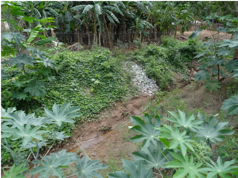
NTC06 a: Detalhe para o enrrocamento; plantio de bananeiras e mix de sementes
