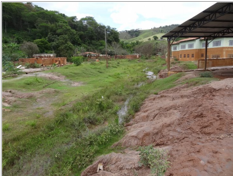
NTG 02 d: Tributário sobre rejeito no contexto do Distrito de Paracatu de Baixo. Processos erosivos severos.
