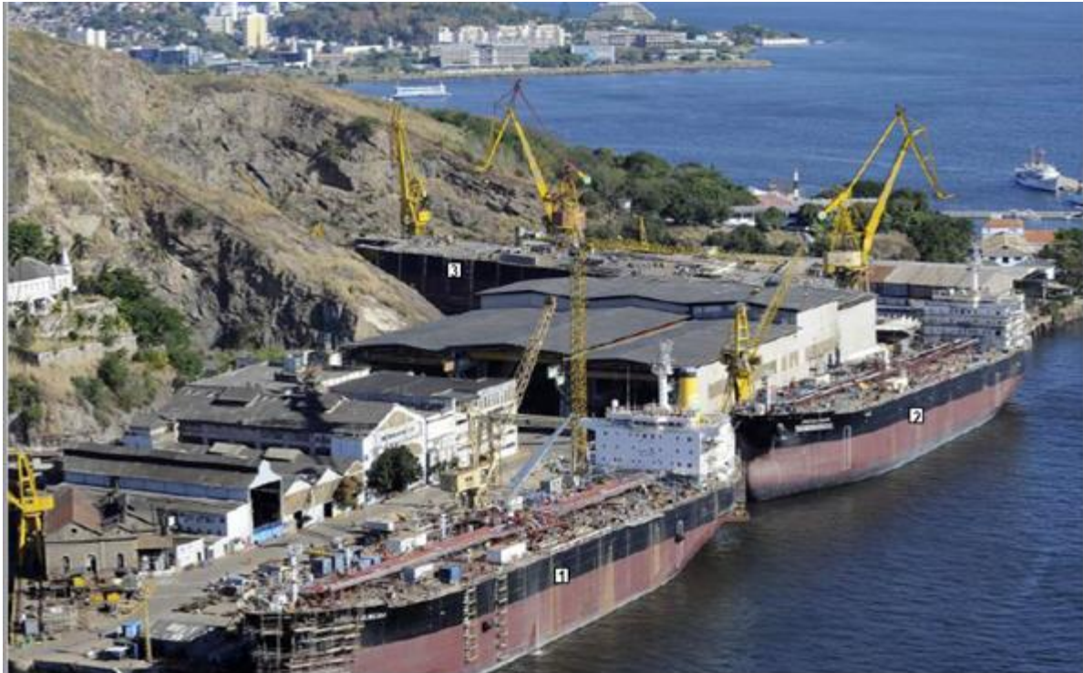
Figura 32. Vista do Estaleiro Mauá (agosto/2012).
