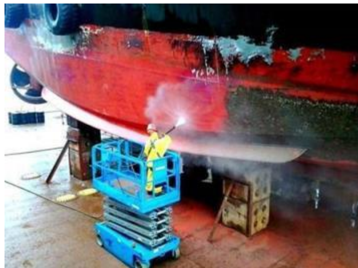
Figura 5 – Hidrojateamento em casco de embarcação.
