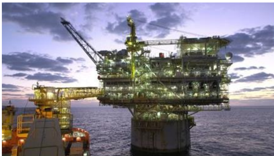
Figura 18. Unidade estacionária de Produção do tipo SPAR.
