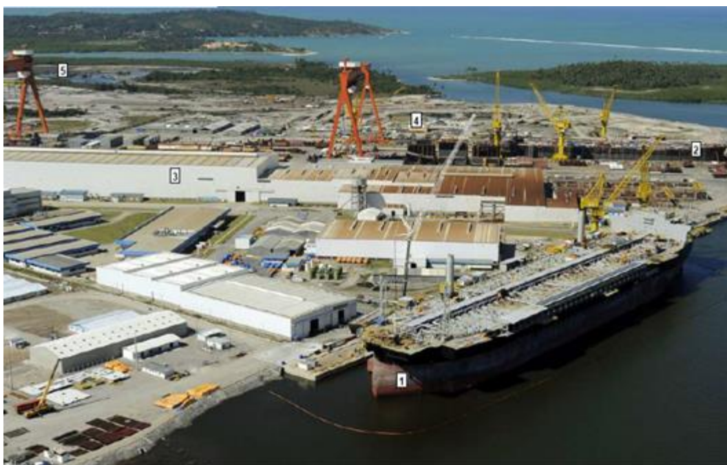
Figura 33. Plataforma P-62 em construção no Estaleiro Atlântico Sul (agosto/2012).
