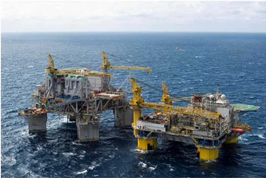
Figura 15. Plataforma P-61 (TLWP) conectada à plataforma de apoio (TAD – Tender Assisted Drilling) – Campo de Papa-Terra– Bacia de Campos.
