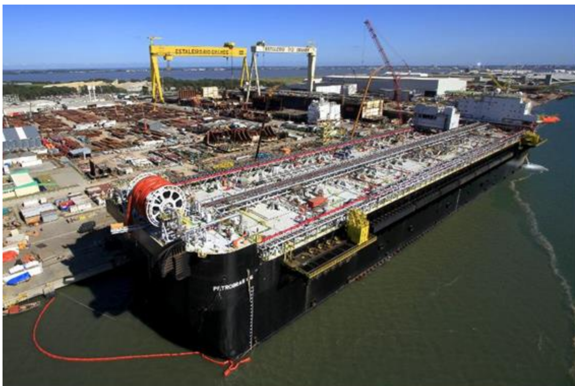
Figura 28. Casco da P-66 atracado no cais sul do ERG 1 (dezembro/2014)
