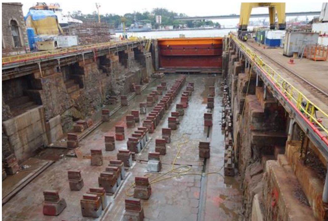
Figura 5. Disposição dos picadeiros no dique seco do Estaleiro Mauá – RJ.
