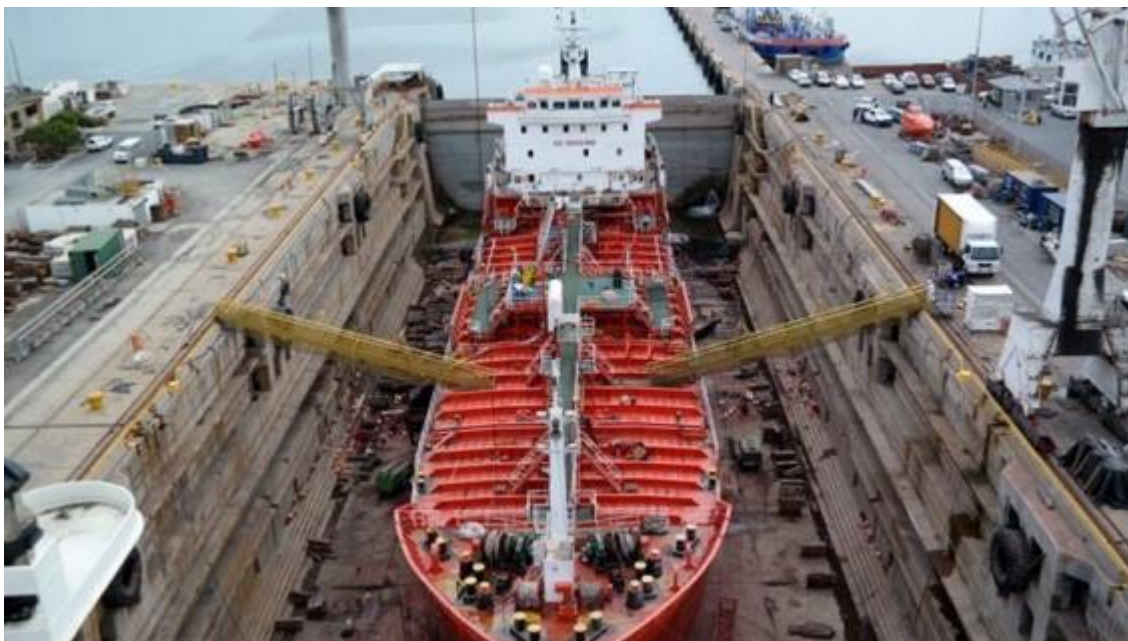
Figura 1 – Aspecto geral de um dique-seco drenado possibilitando a realização de operações (construção, limpeza, reparo, pintura) - http://worldmaritimeneews.com/archives/178799/spotted-cape-towns-dry-dock-gets-busy/
