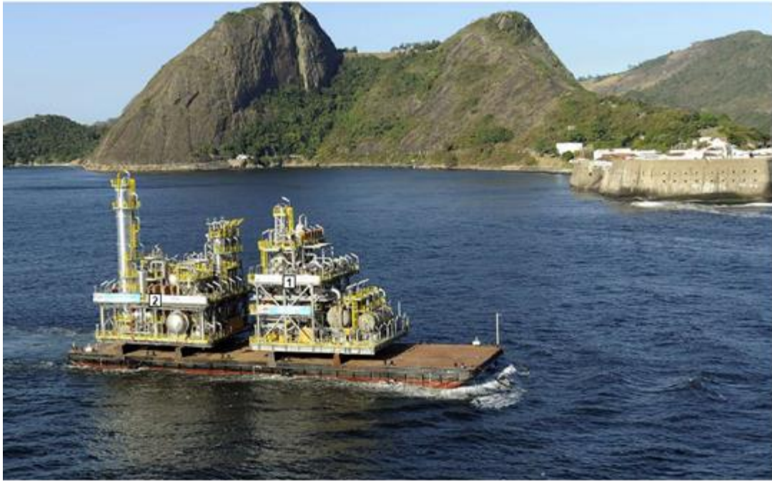
Figura 26. Exemplo de dois módulos da Plataforma P-58, construídos no canteiro da UTC em Niterói (RJ), sendo transportados por balsa para um estaleiro no Rio Grande do Sul (agosto/2012).
