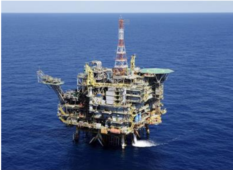
Figura 12 . Plataforma de Mexilhão (PMXL-1) – Campo de Mexilhão – Bacia de Santos.
