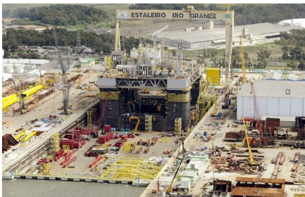
Figura 27. Plataforma P-55 em construção no Estaleiro do Rio Grande (setembro/2012).
